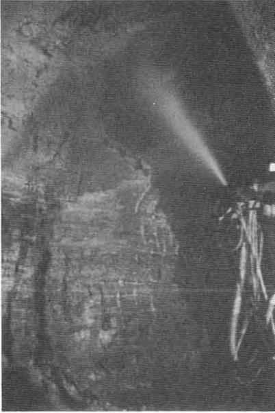
Abb. 8. Schlechte Düsenführung mit zu großem Düsenabstand und zu großer Luftmenge.
