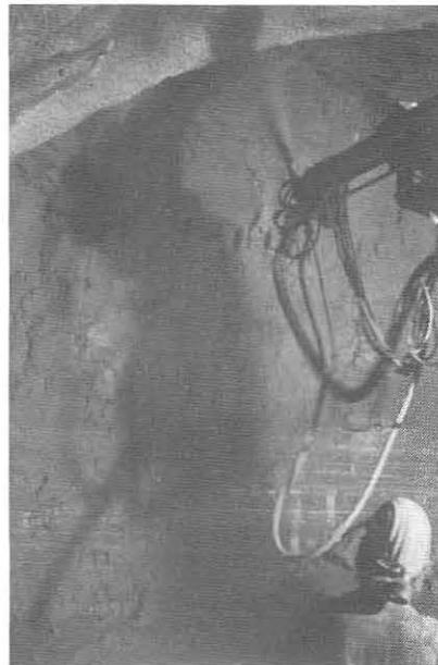
Abb.7. Optimale Düsenführung mit einem Düsenabstand von 50 - 100 cm.
