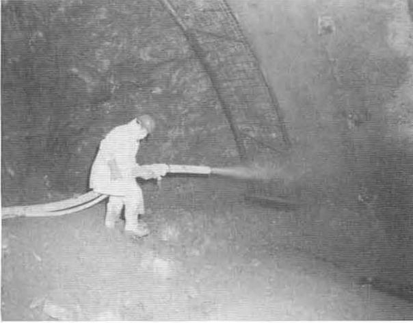
Abb. 6. Tunnel Altengronauer Forst/BRD: Kalottensicherung im geschichteten Sandstein.
