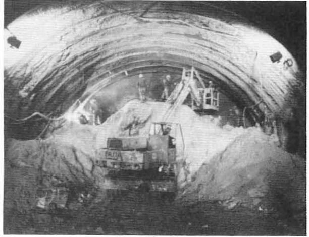
Abb.5. Ganzsteintunnel/Steiermark: Vortrieb in plastischen Myloniten.
