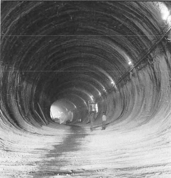
Abb. 23: Tunnelröhre vor Einbringung der Innenschale
