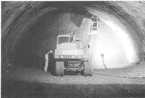
Bild 1: Wirtschaftlicher Naßspritzbeton im Kalotenvortrieb
