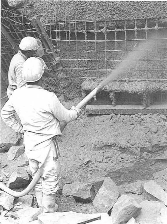
Bild 5: Schlauchdüse beim Naßspritzverfahren
