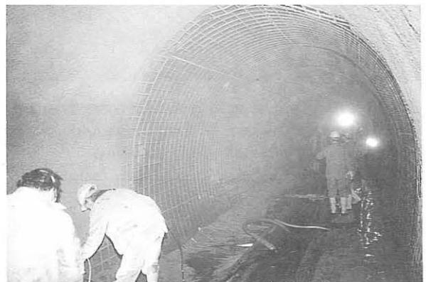
Bild 21: Erstellen der zweiten Spritzbetonlage im Abwasserstollen Frasdorf-Aschau
