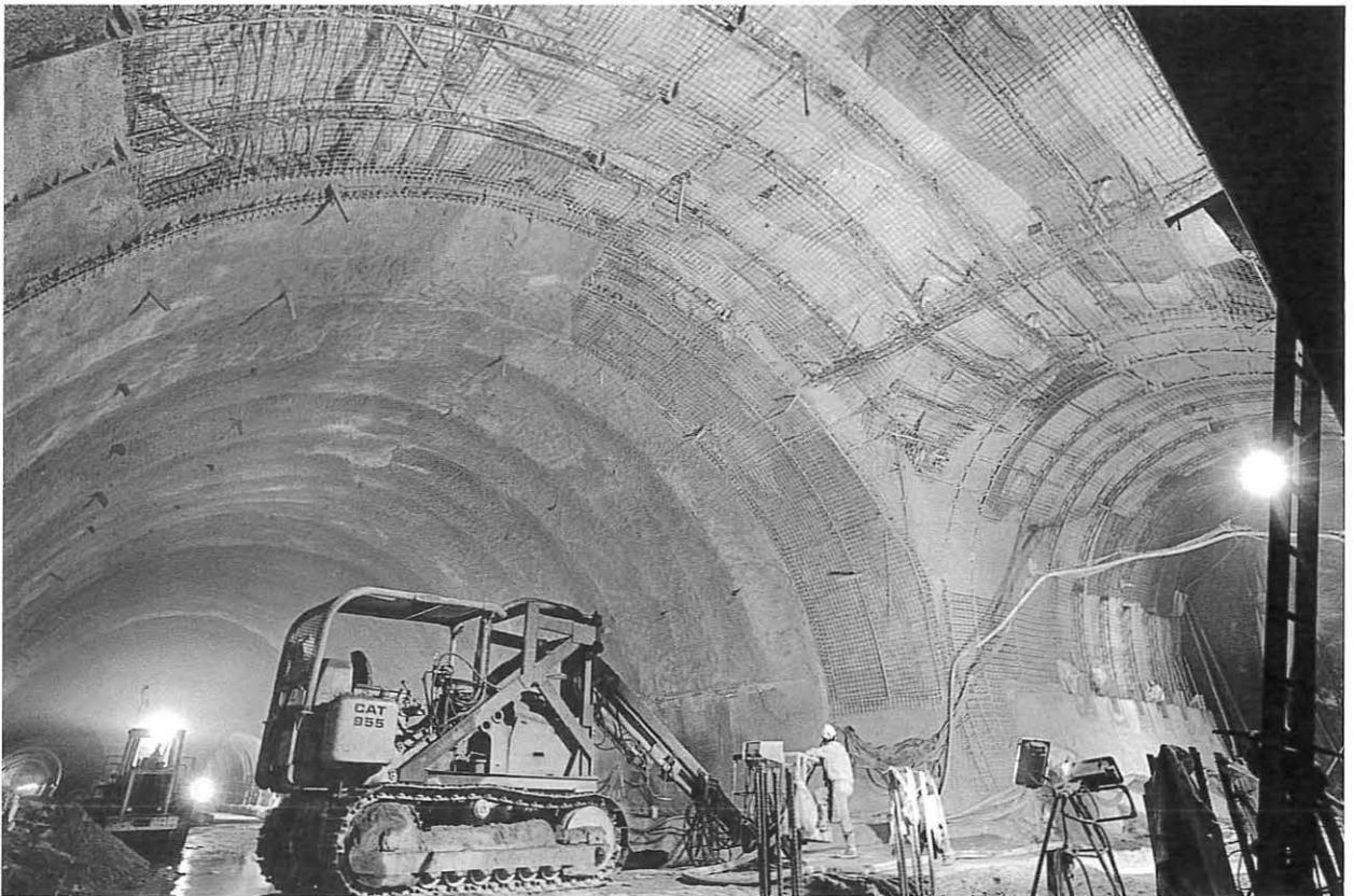
*Bild 1: Aufbringen der letzten Spritzbetonschicht in einem Kreuzungsweichentunnel*
