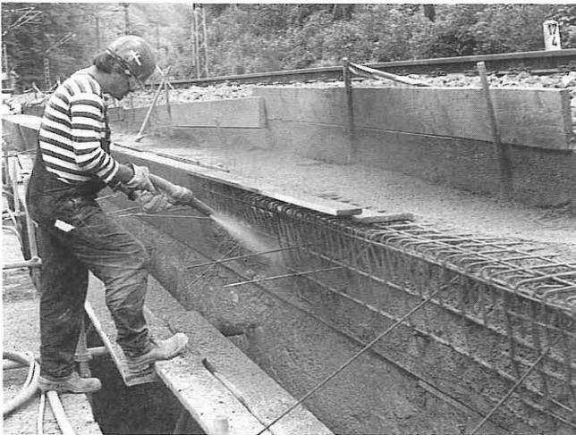
Bild 4: Auftragen des Spritzbetones
