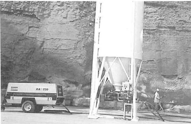
Bild 3: Baustelleneinsatz des Rombold-Systems in Form eines 22 m<sup>3</sup>-Standsilos
