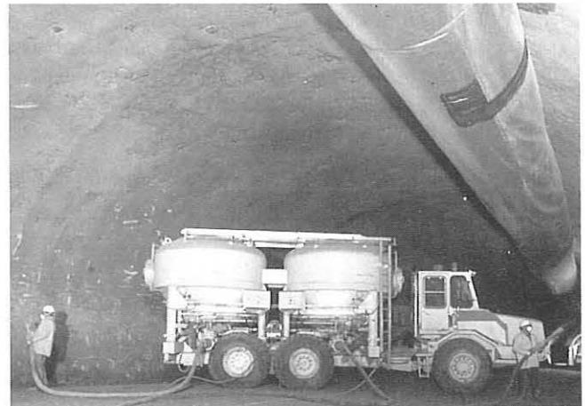
*Bild1: Rombold-Spritzmobil mit zwei Druckkesseln und unten montierter Dosierblasschnecke*
