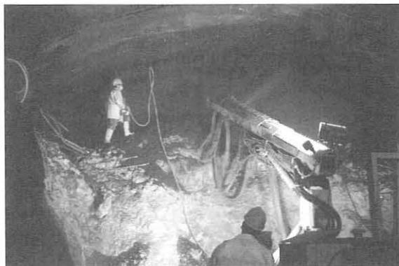
Bild 5: Spritzarbeiten im Bereich der Kernkalotte - Ulmenstollenvortrieb
