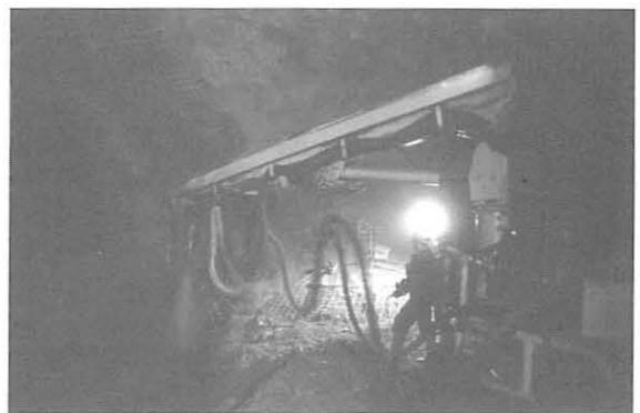
Bild 6: Spritzarbeiten im Kalottenvortrieb
