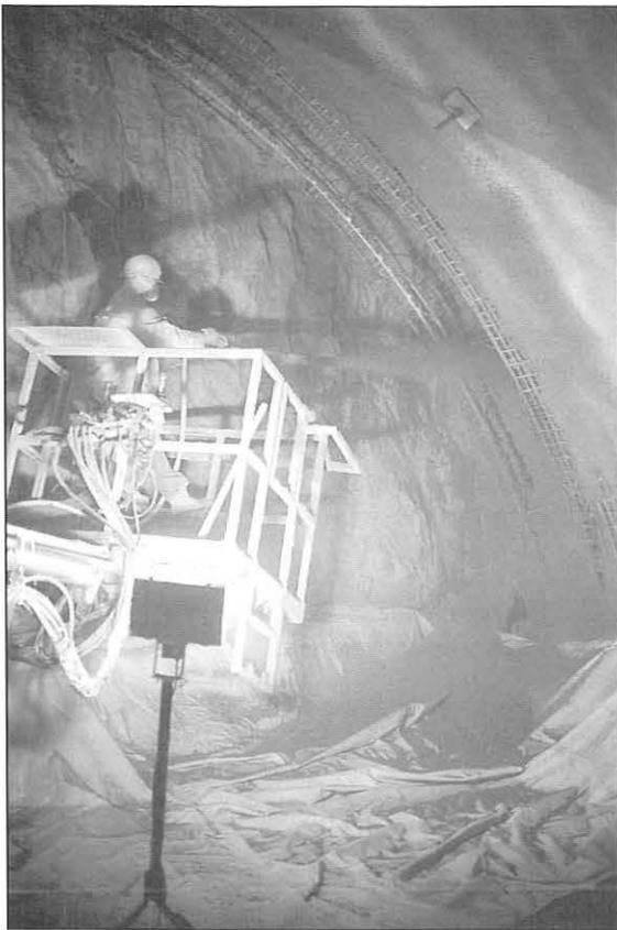
Bild 12: Auffangen des Rückpralls mittels untergelegter Plane
