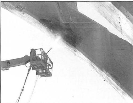
Bild 2: Mobile hydraulische Plattform, die zur Durchführung der Instandsetzungsarbeiten bis 45 m ausgefahren werden kann
