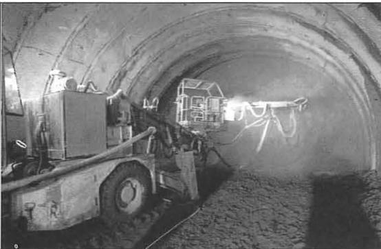
Bild 4: Spritzgerät mit 1000 l BE-Mittel-Tank
