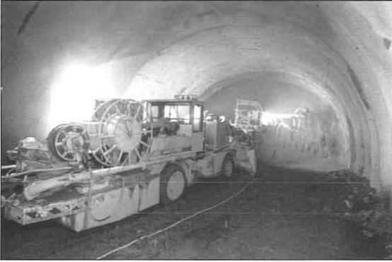
Bild 3: Mobile Naßspritzanlage
