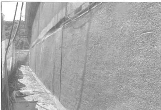
Bild 7: Betonvorsatzschale 1. Horizontaler Bauabschnitt. Nachbehandlung durch wasserzuführende Maßnahmen
