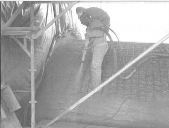
Bild 4: Spritzbetonauftrag an der HWE auf gekrümmte und geneigte Flächen
