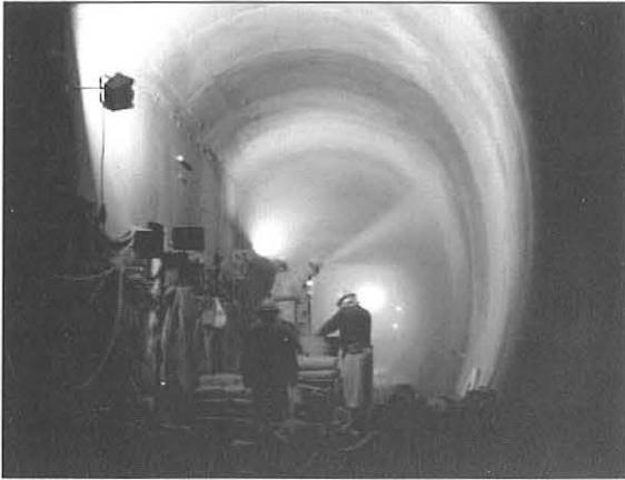
Bild 16: Auftrag der 5 cm starken Deckschicht
