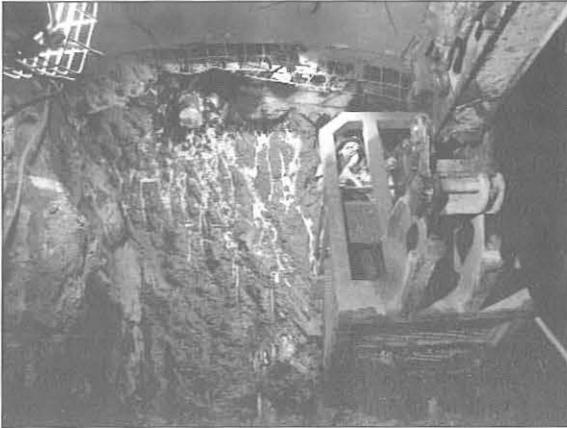
Bild 6: Vereister Baugrund im Kalottenvortrieb
