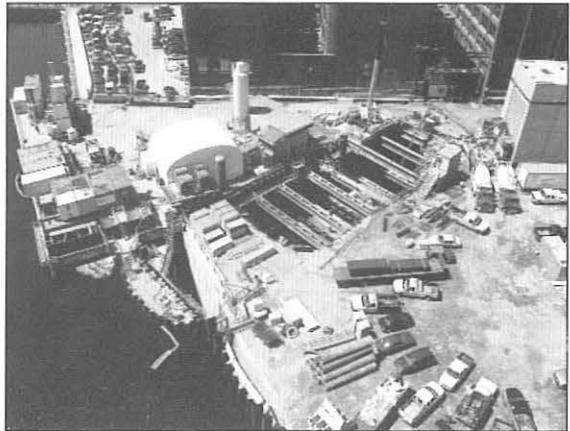
Bild 10: Stationäre Aufstellung der Komponenten der Spritzbetonanlage am Schachtrand
