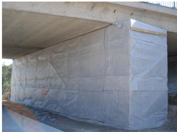
*Bild 8: Einhausung der Stützenreihe zum Schutz gegen Wind*
