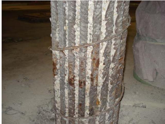
*Bild 6: Enge Bewehrungsführung macht Betonabtrag hinter der Bewehrung unmöglich*
