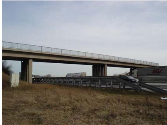
*Bild 7: Typische Bauart der Überführungsobjekte an der A 2*
