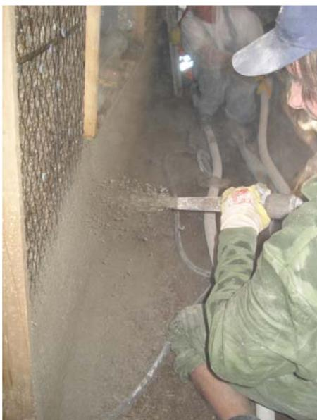
*Bild 11: Einbetten des Anodengitters*
