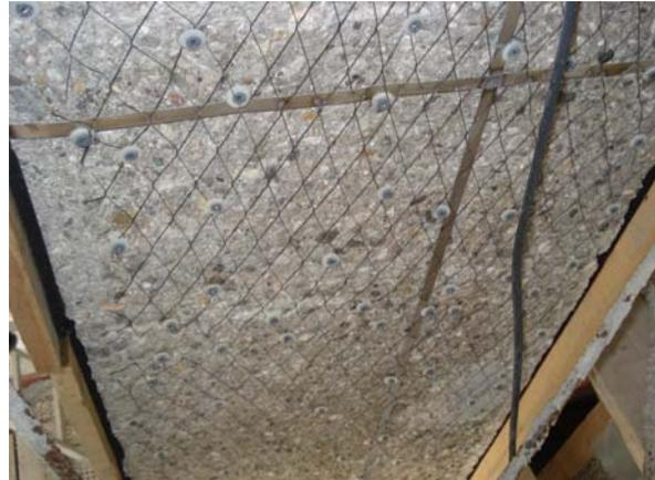
*Bild 10: Für Einbettung vorbereitete Stützenfläche*
