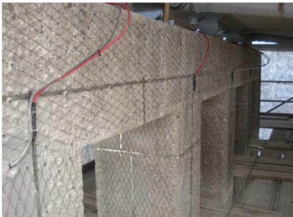
*Bild 4: Einzubettende Titannetze auf der Stützenreihe einer Überführung*
