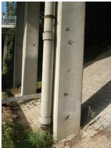
*Bild 2: Örtliche Betonabplatzungen über korrodierender Bewehrung an den Stützen einer Brücke*
