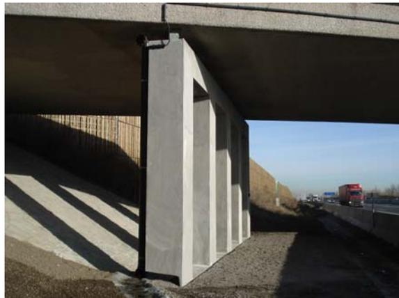
*Bild 15: Fertig gestellte Stützenreihe nach der Inbetriebnahme des KKS*
