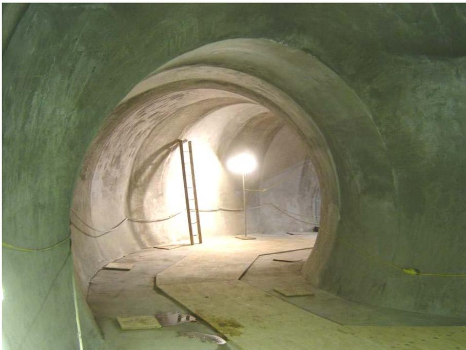
*Bild 12: Fertiggestellter LaserShell-Querschlag nach Aufbringen der Glättlage
