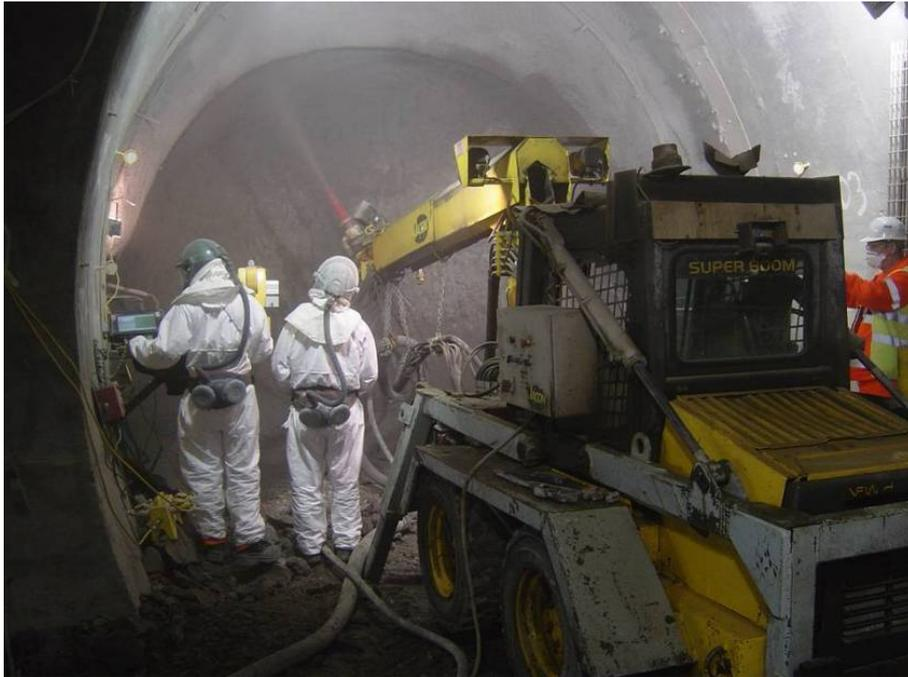
*Bild 11: Spritzbetonauftrag mit Roboter und TunnelBeamer*
