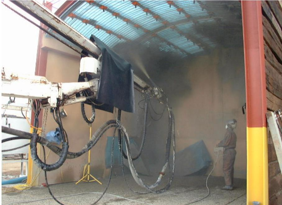
*Bild 42: Düsenführer während praktischer Prüfung im Zulassungstest*
