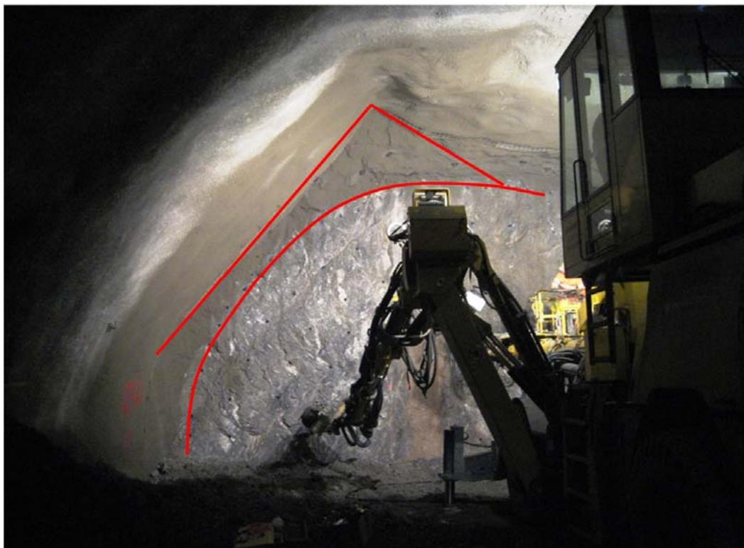
*Bild 3: Markante Trennfläche im linken Kämpfer des Ostvortriebes führt zu geologisch bedingtem Überprofil (Foto: Arge Tunnel Roppen).*
