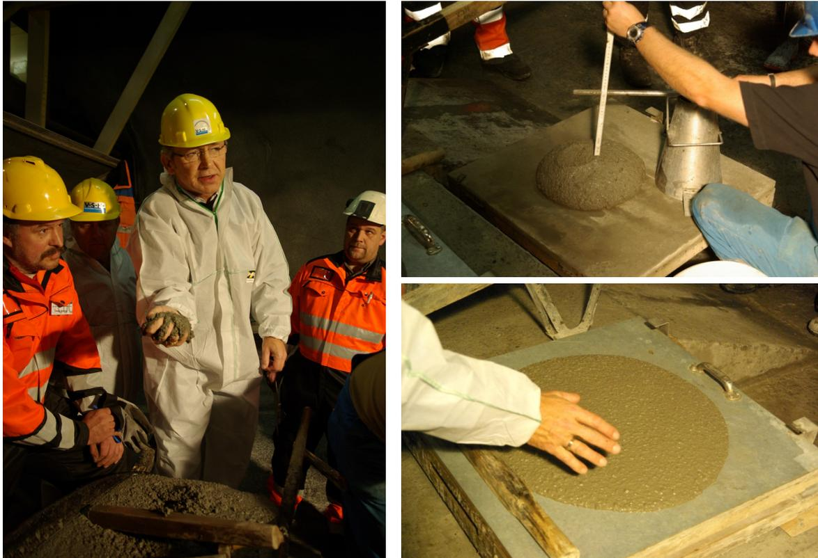
*Bild 5: Auszubildner und Kursleiter Odd-Bjørn Kleven demonstrieren das „Fühlen“ und die Verarbeitbarkeit eines guten Spritzbetons.*
