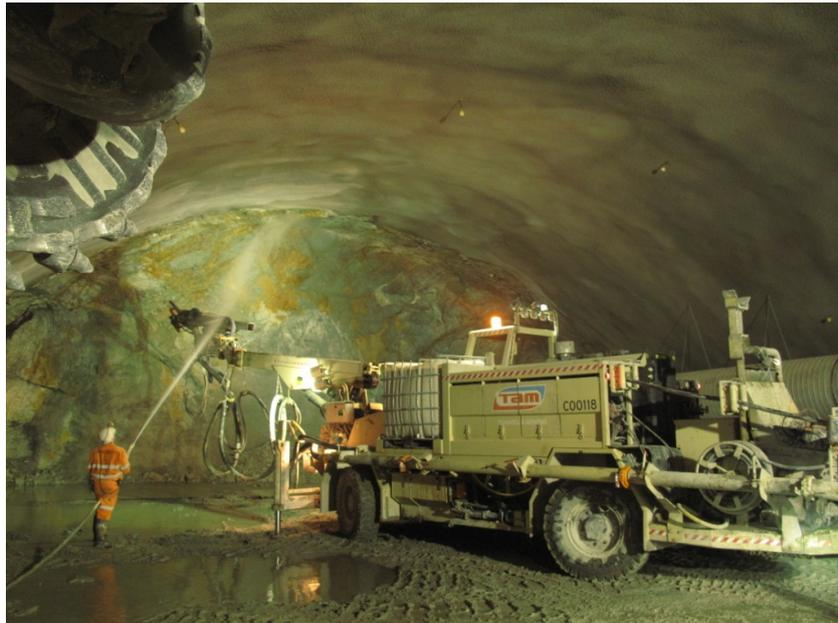
*Bild 7: Düsenführer der ARGE Thiess-Holland veranschaulicht im Brisbane Airport Link Tunnel wie die Auftragsfläche vor dem Aufbringen des Spritzbetons präpariert wird. (Das Foto wurde freundlicherweise von BrisConnections zur Verfügung gestellt)*
