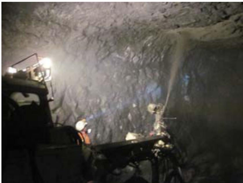
*Bild 8: Ein Düsenführer der Lisheen Grube zeigt seine praktischen Fähigkeiten beim Betonspritzen. (Das Foto wurde freundlicherweise von der Lisheen Mine zur Verfügung gestellt).*
