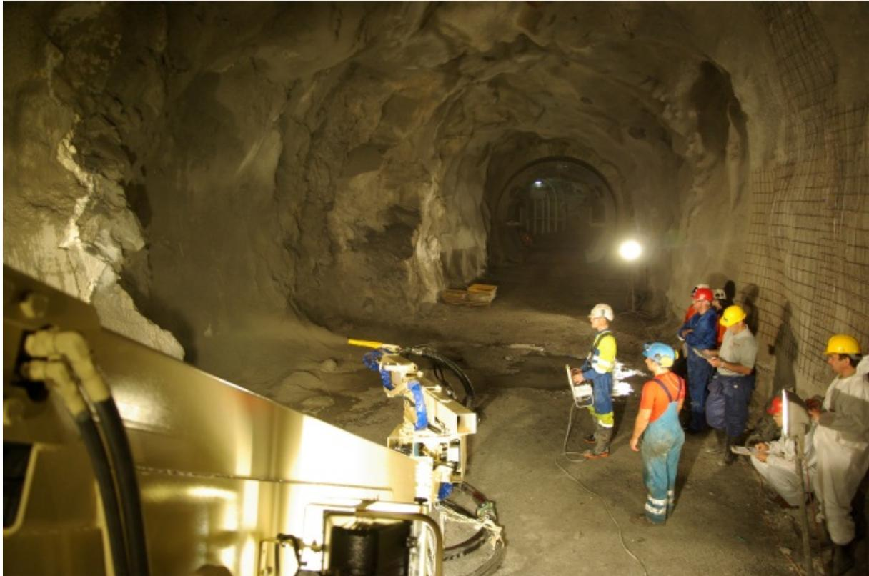
*Bild 6: Im Hagerbach Versuchsstollen, Schweiz, wird den Prüfern das korrekte Betonspritzen nach EFNARC Vorgaben gezeigt.*
