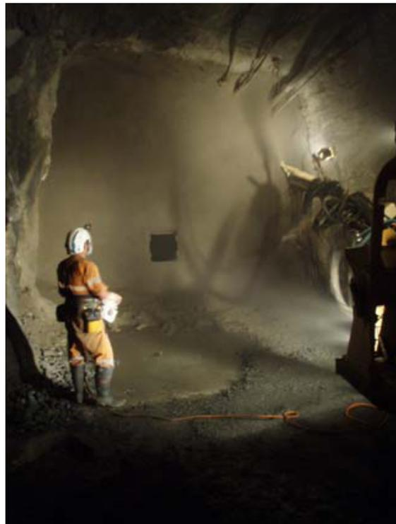
*Bild 9: Ein Jetcrete Düsenführer zeigt seine praktischen Fähigkeiten in der Newcrest Goldmine, Telfer, West Australien. (Das Foto wurde freundlicherweise von Jetcrete Australia zu Verfügung gestellt).*
