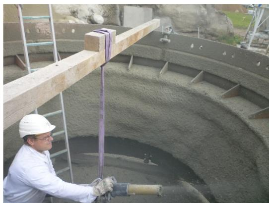
*Bild 11: Herstellen der Spritzbetoninnenschale (Foto: Schretter & Cie)*
