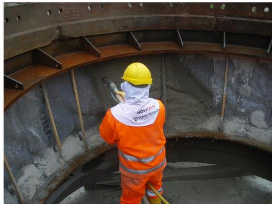
*Bild 10: Aufbringen der Schutzschicht auf den Schlauch (Foto: Schretter & Cie)*
