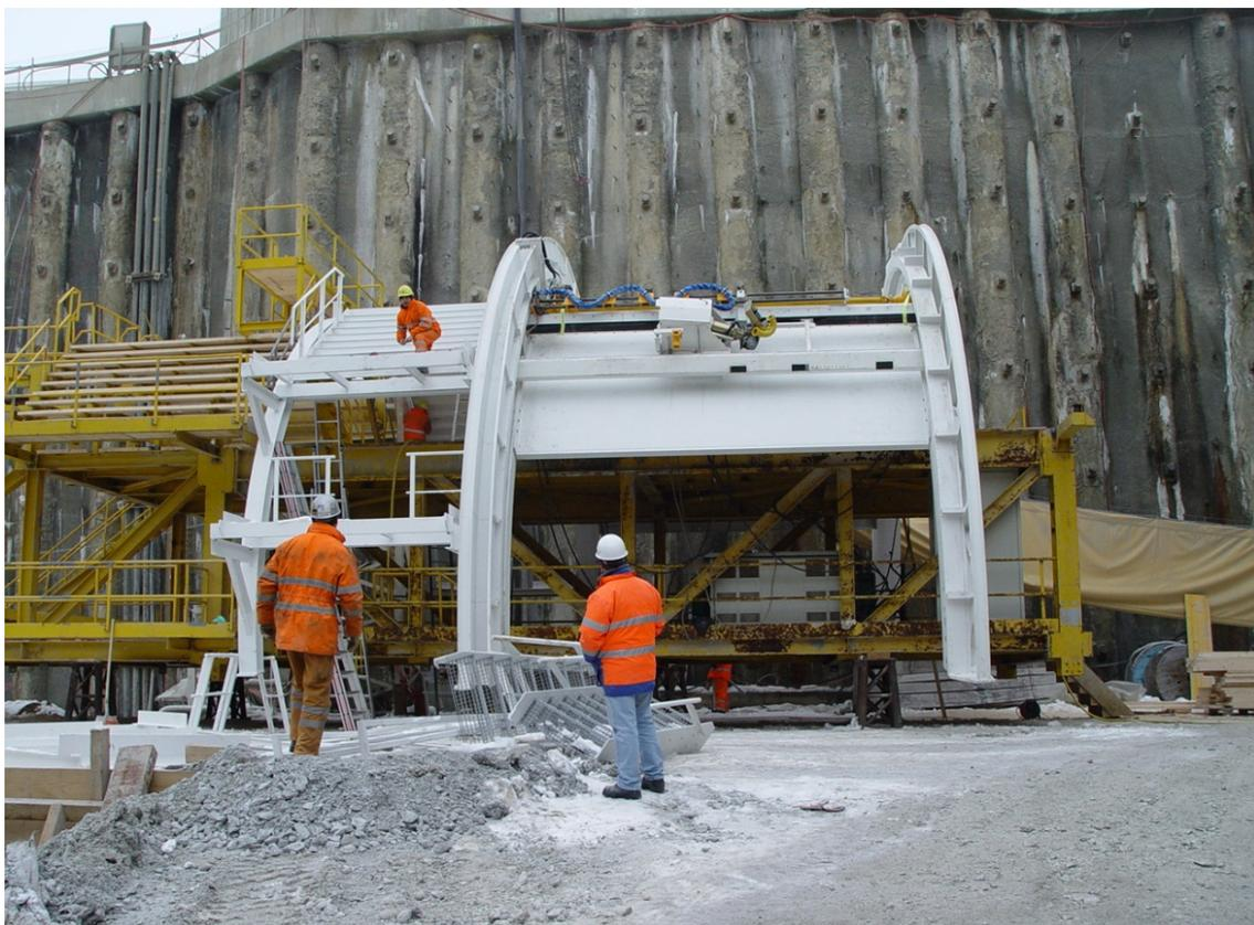
*Bild 3: Spritzmanipulator mit zwei Spritzdüsenwagen (Bereich L2) während der Baustellenmontage.*
