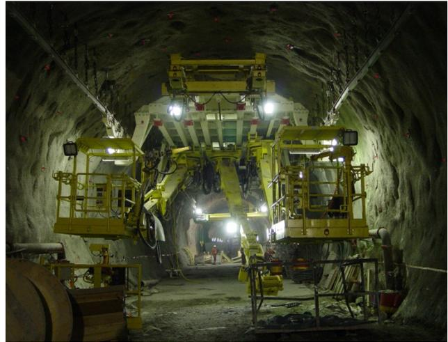
*Bild 14: Streckenausbaumaschine mit Arbeitskörben, Versetzarm und Spritzbetonmanipulator (Gotthard-Basistunnel – Teilabschnitt Sedrun).*
