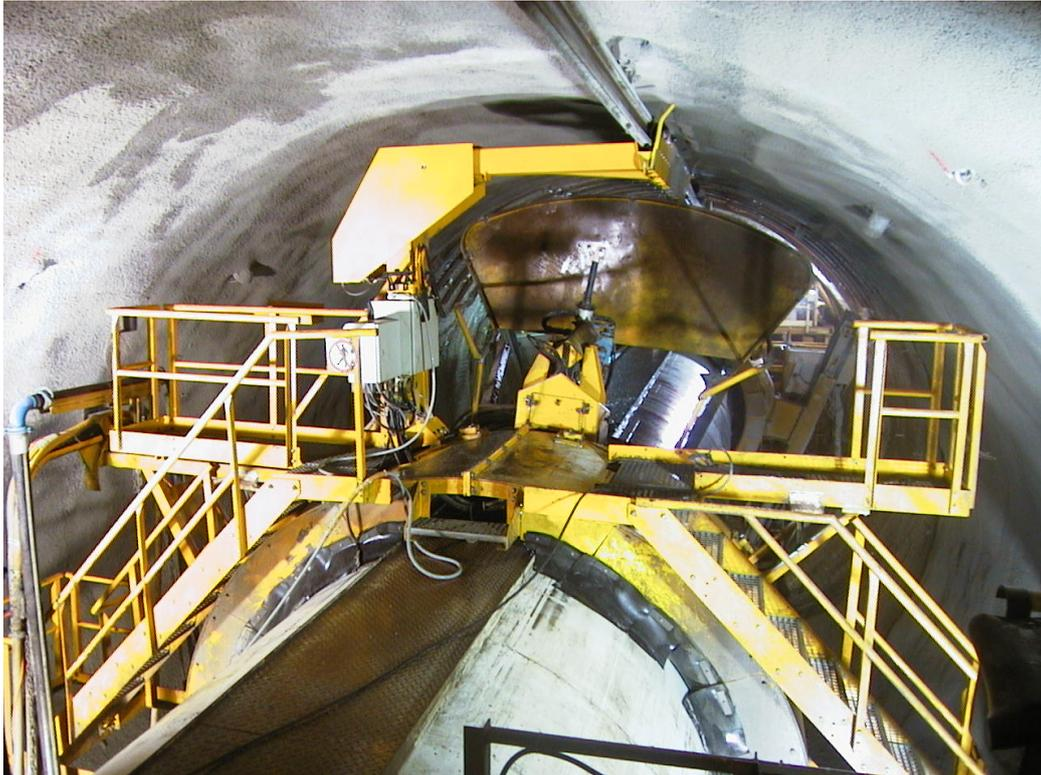
*Bild 5: Spritzbetonmanipulator im Konsolidierungsbereich (Gotthard-Basistunnel – Teilabschnitt Amsteg/Erstfeld).*
