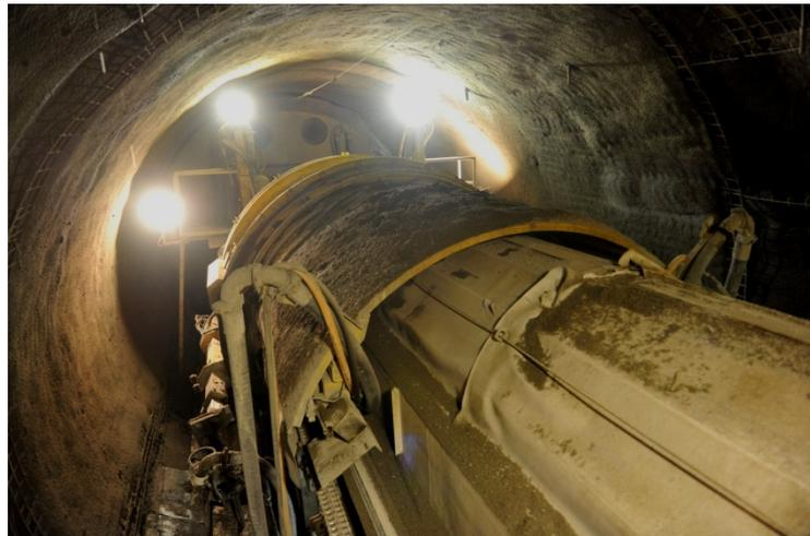
Bild 10: Rückprallentsorgung (unten links) und Abdichtwand für die Absaugung des Staubes.
