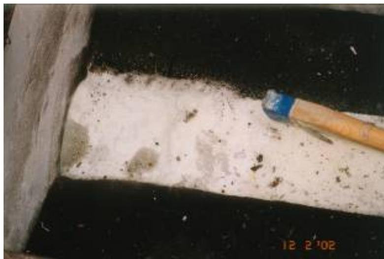
Bild 1: „Beinahe“-Vollverschluss mit harter Verkrustung [1]
