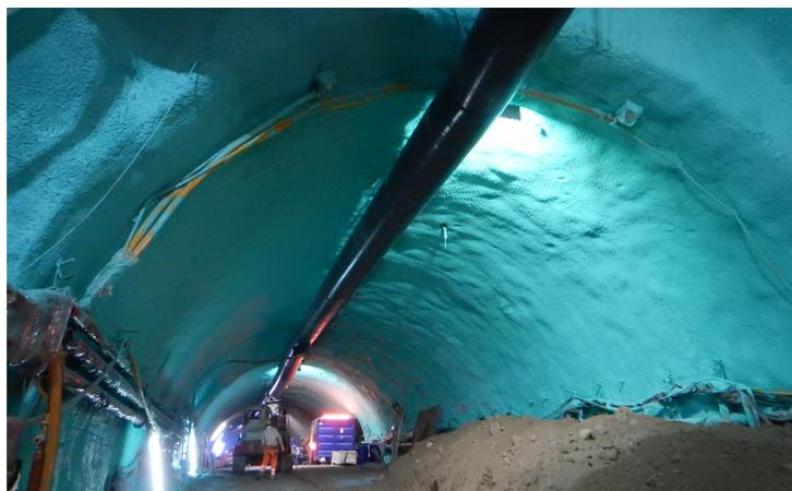
*Bild 7: Flächige Nachbehandlung der Spritzbetonaußenschale mit Mapelastic TU (Bild: BeMo-Tunnelling)*
