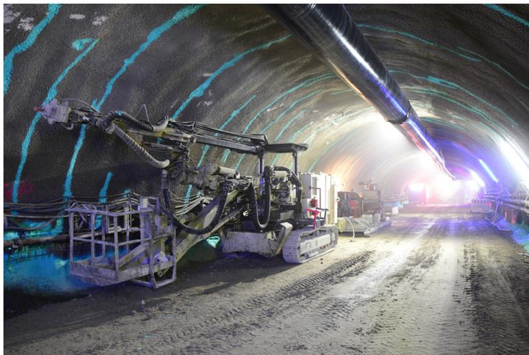
**Bild 8: Gezielte Nachbehandlung der Spritzbetonaußenschale mit Mapelastic TU (Bild: BeMo-Tunnelling)**
