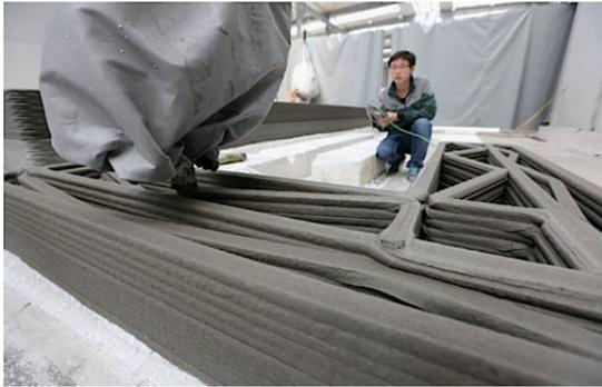
*Bild 1: Extrudieren einer Wand durch die chinesische Firma WinSun
