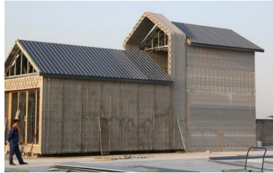
*Bild 2: Gedrucktes Haus der chinesischen Firma WinSun (Bild: WinSun [5])*
