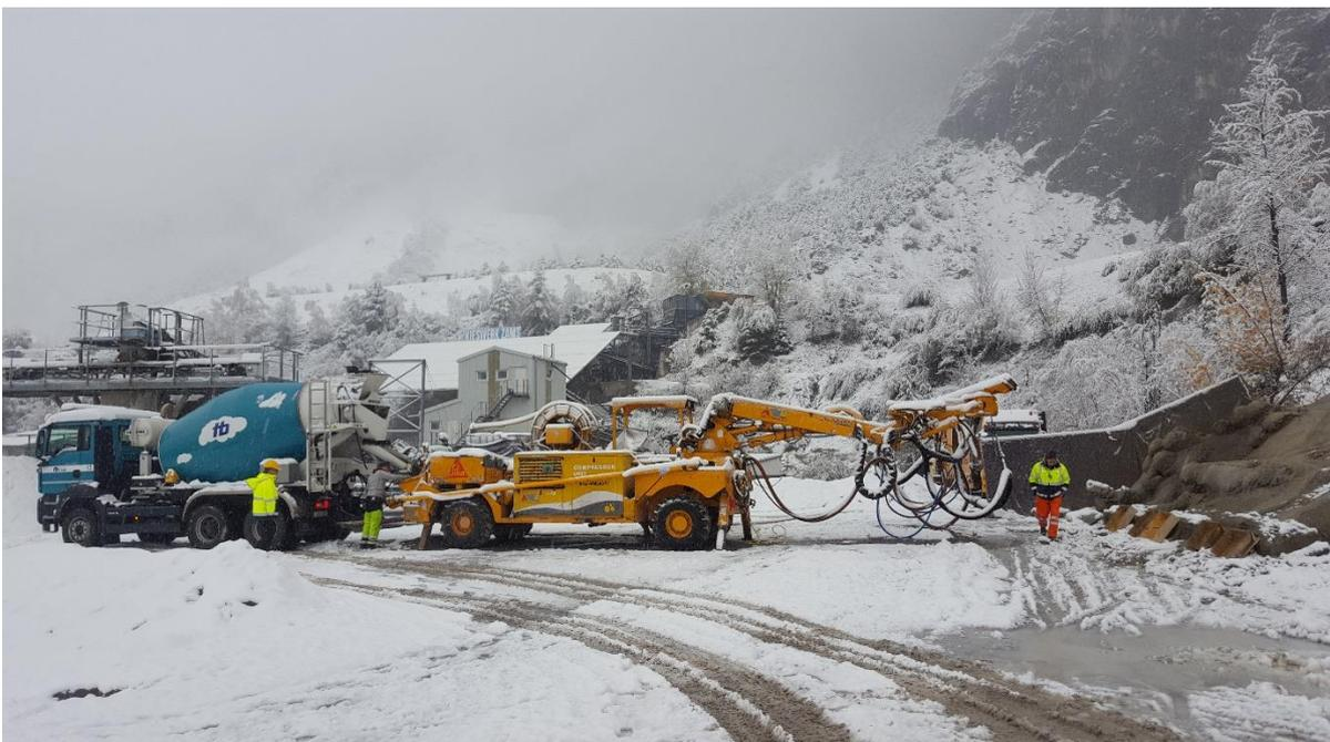
Bild 4: Spritzmobil und seine Beschickung
