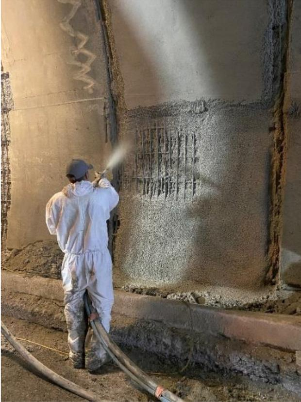
Abb 4 Applizieren des Spritzmörtels
