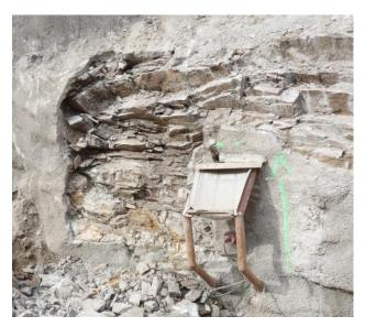
Abb. 8 Zerklüftetes Gestein unter altem Spritzbeton. Links: Schutzabdeckung eines Messinstrumentes
