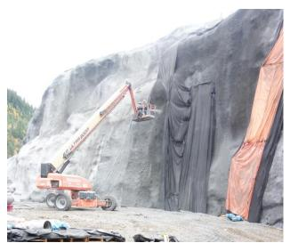
Abb. 6 Spritzbetoneinbau von der Hebebühne
